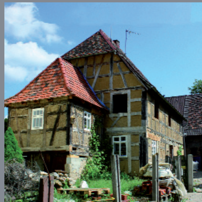
Fachwerkhaus mit Lehmgefachen, Lehmminndämmung, Fensterreparatur und Ergänzung zu Kastenfenstern, neue Heizung
