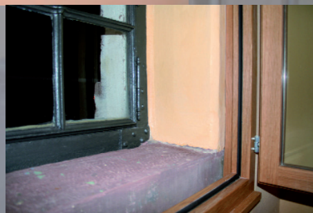
Ehem. Heizhaus, heute Wohnhaus, Erhalt der Eisenfenster und Ergänzung mit isolierverglasten Kastenfenstern in der Ebene des Wärmedämmputzes
