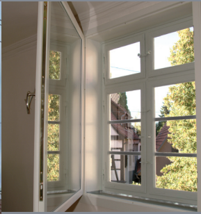
Historisches Einfachfenster mit isolierverglasem Kastenfenster
