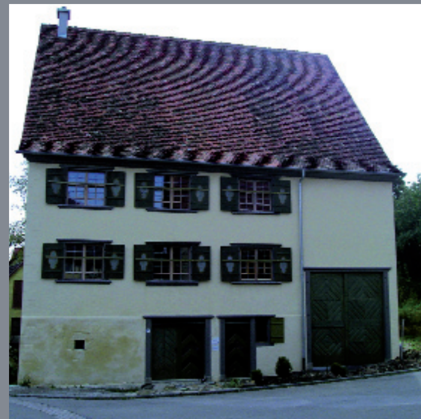
Wohnhaus Außendämmung der Obergeschosse, Fensterreparatur und Ergänzung zu Kastenfenstern
