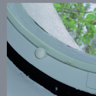
Umbau Einfachfenster zu einem Verbundfenster
