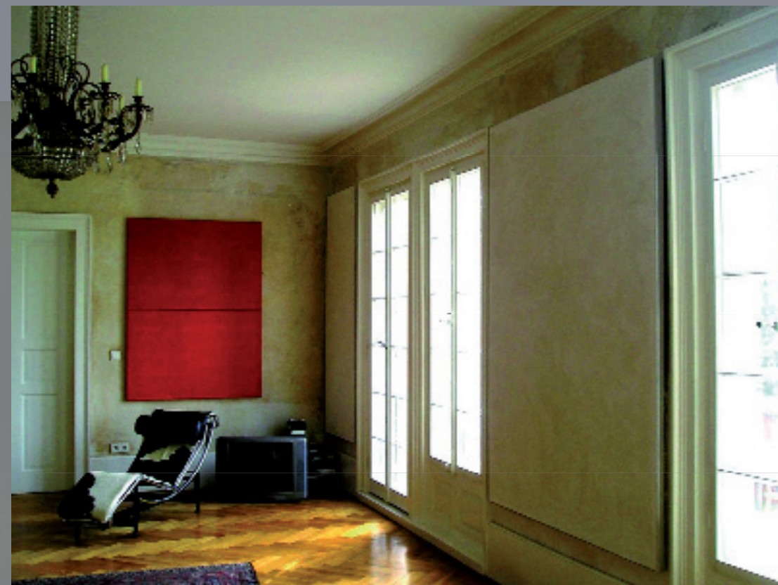
Außenwandheizung in Gestalt eines Wandbildes
