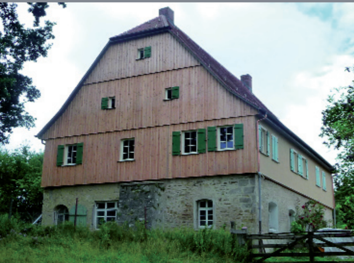
Wohnhaus: EG mit Innendämmung und Fensterreparatur; OG Außendämmung unter Holzschalung, Fenstererneuerung; DG mit Bodendämmung, neue Heizungsanlage
