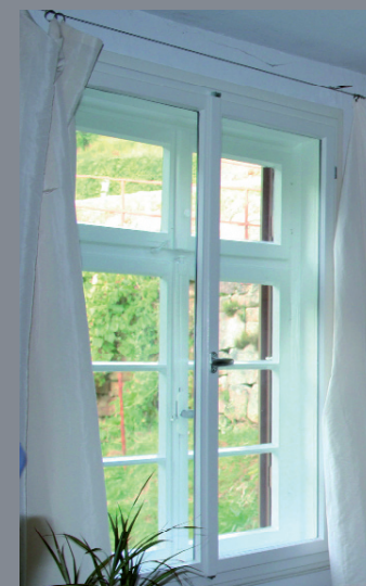
Umbau eines Einfachfensters zum Kastenfenster mit Isolierverglasung innen
