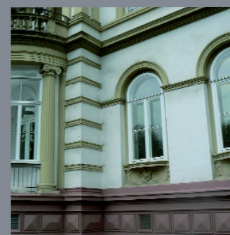
Wohnhaus mit bauzeitlichen Winterfenstern
