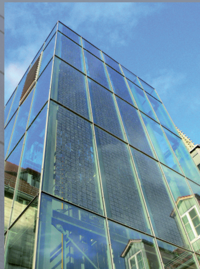
Erschließungsbauwerk mit integrierter PV-Anlage in den Glasscheiben
