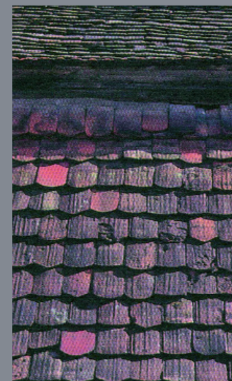
Historische Ziegeleindeckung / Handstrichbiber
